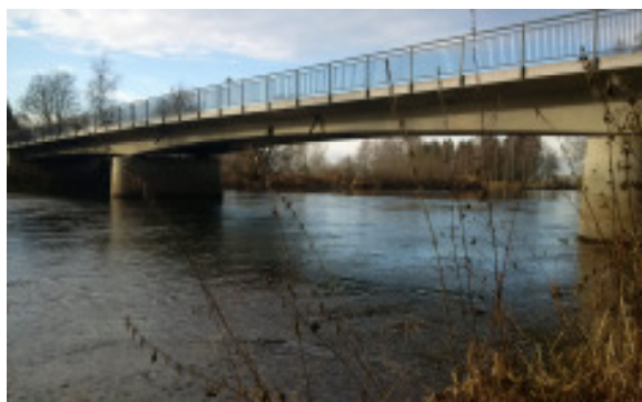
Bild Zustand vor Umsetzung
